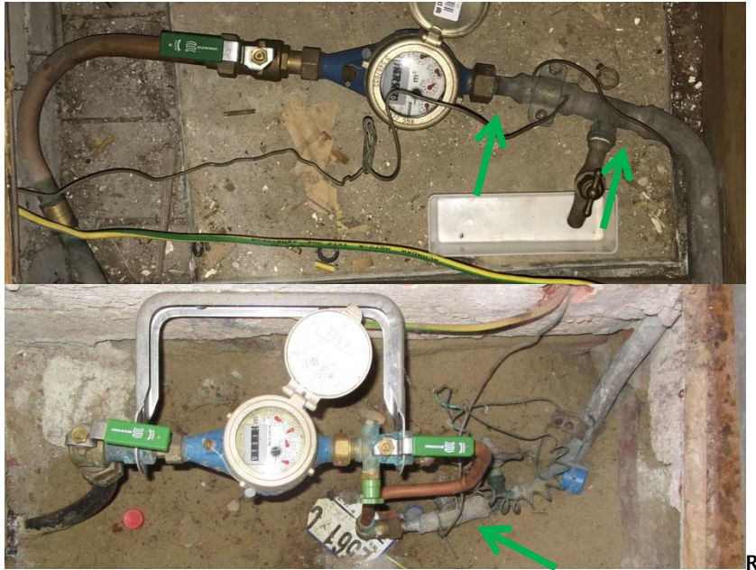
FIGUUR 14. TWEE VOORBEELDEN VAN FOTO'S WAAROP LODEN ONDERDELEN TE ZIEN ZIJN. HET LOOD KAN ONDER ANDERE WORDEN HERKEND AAN DE KLEUR, RELATIEF GROTE BUITENDIAMETER EN AAN DE TRECHTERVORMIGE OVERGANGEN TUSSEN BUISDELEN (AANGEGEVEN MET DE PIJL)
